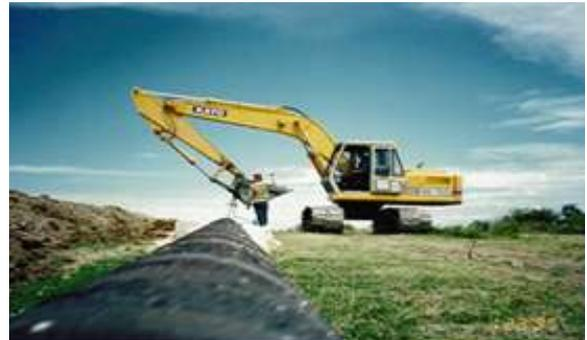
Apertura de zanjas, instalación de tubería en zanja y cruces perforados.
