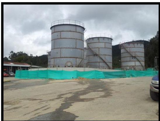
Tanques de almacenamiento de bases lubricantes de 4500 barriles
