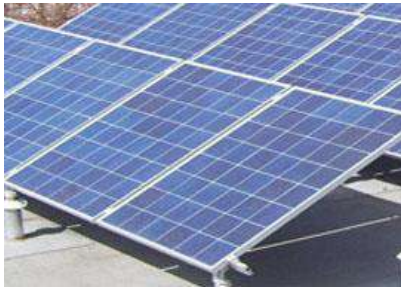
HARRAHS ENTERTAINMENT Fotovoltaica en tejado de 400kW Ingeniería básica y detalle
