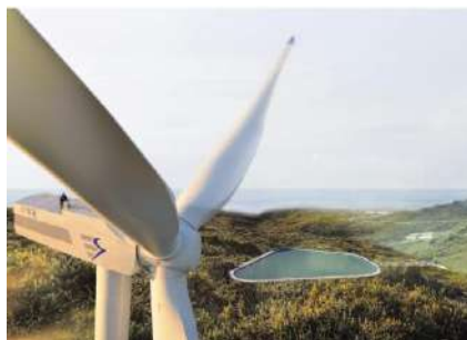
GORONA DEL VIENTO, El Hierro Almacenamiento de Energía (embalse) de Parque eólico 10 MW demanda eléctrica Ing. detalle y Supervisión Obra
