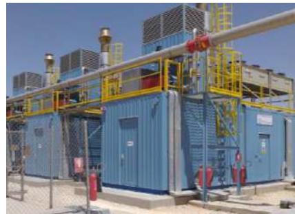
Gas Vertedero AL GHABAWI a Energía Municipio Great Amman, Jordania WORLD BANK + ERBD 900.000tpy, 156 pozos, 5MW Apoyo a la Operación
