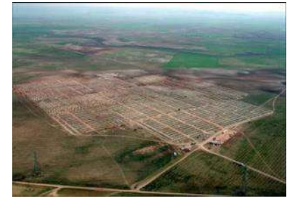
SUNPOWER Parque Fotovoltaico de 12 MW Ingeniería básica y detalle
