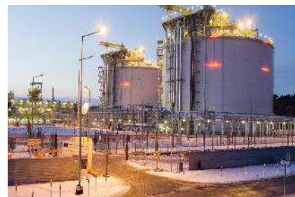
Ampliación de la Terminal de Regasificación de GNL en Świnoujście (Polonia)
