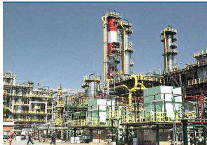
Sistema de recepción de LPG ya aumento de capacidad en la Refinería de Tarragona de REPSOL (España)
