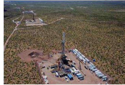
UOGD Proyecto piloto Fracking Pozos Platero – Kale. Ingeniería Básica y de detalle ECOPETROL
