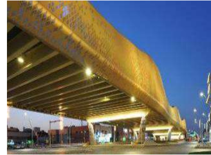
Carretera Abi Bakr Al Siddiq (Arabia Saudí) 12 km de longitud Ingeniería conceptual y detalle, y dirección de obra
