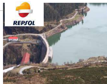
Central Hidroeléctrica de AGUAYO para REPSOL, España 1000 MW Ing. Básica y Detalle
