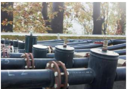
Gas Vertedero SAN MARCOS a Energía San Sebastián 135.000 tpy, 60 pozos, 1.8 MW Estudio de viabilidad y servicios EPCM
