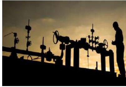
Acondicionamiento estratégico de facilidades de Gas Campo Cupiagua, Colombia. Ingeniería de Detalle ECOPETROL
