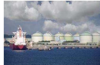
Proyecto de GNL de Matanzas (Cuba) FRSU con terminal de Regasificación
