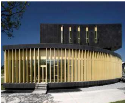
Nuevo campus del CEIBS, China 18,000m 2 Arquitectura, estructura, instalaciones y supervisión de obra
