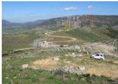
PARQUES EÓLICOS EN SOMOVA Y FECATEI JORGE GROUP (RUMANIA) Ingeniería Básica y de Detalle
