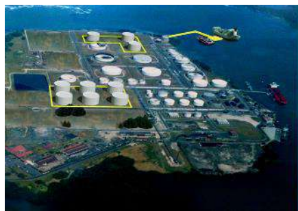
Terminal de Almacenamiento de VOPAK en Panamá Ingeniería de Detalle
