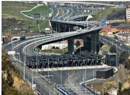
Circunvalación Sur Bilbao (España) 15 km de longitud Ingeniería de detalle y supervisión de obra
