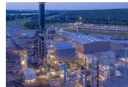
Proyecto JAGUATIRICA II (Brasil) para producción de Gas de Pozo, tratamiento y licuefacción, gaseoducto virtual, regasificación y Ciclo Combinado
