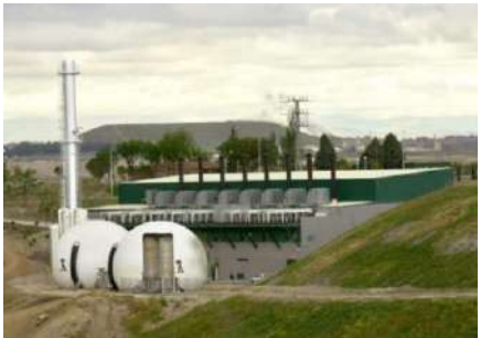
Gas Vertedero VALDEMINGOMEZ a Energía Madrid Tratamiento gas + almacenamiento gas + Planta Generación 20 MW + 10% de inyección de gas a red GN Ingeniería básica y detalle
