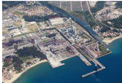
Terminal de GNL de pequeña escala (Bunkering) para ENDESA en Algeciras (España)
