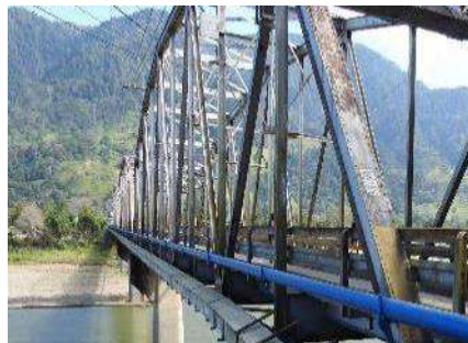
Proyectos de Carreteras en Costa Rica 120 km en 7 proyectos urbanos e interurbanos Diseño preliminar y detalle
