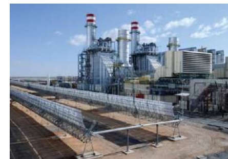
CTCC + Campo Solar de AIN BENI MATHAR ABENGOA (Marruecos) Ingeniería básica y detalle
