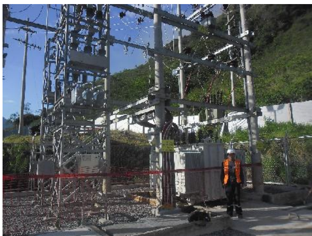
Instalación de Banco de Compensación en 34.5KV, SE Casa Maquinas
