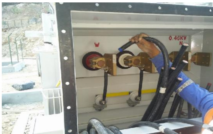
Instalación de los terminales del transformador de distribución de 2.5 MVA 22,9/0.46 KV
