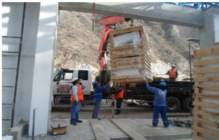
Descarga de celdas de media tensión y tableros de distribución
