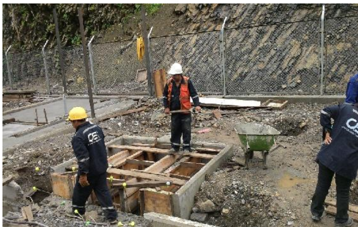
Obras civiles, cimentación para transformador y grupo electrógeno, SE
