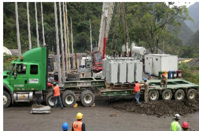
Traslado de almacén a SE de transformador de 3.75MVA 34.5/0.46KV
