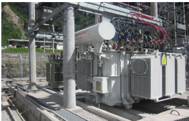
Conexionado de transformador de 3.75MVA
