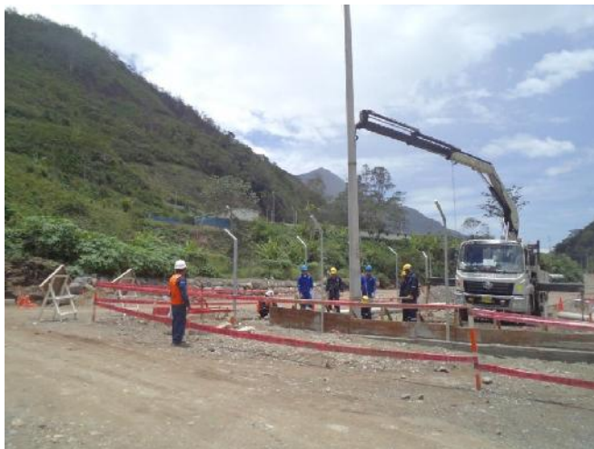
Instalación de pórtico en SE 3,5 MVA Casa Maquinas – CH Chaglla
