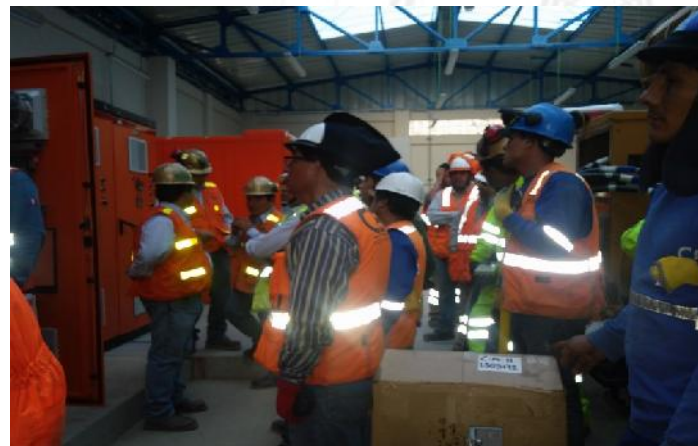
Pruebas y puesta en servicio de la SE Filtrados de la Planta de Relaves de Yuracyacu
