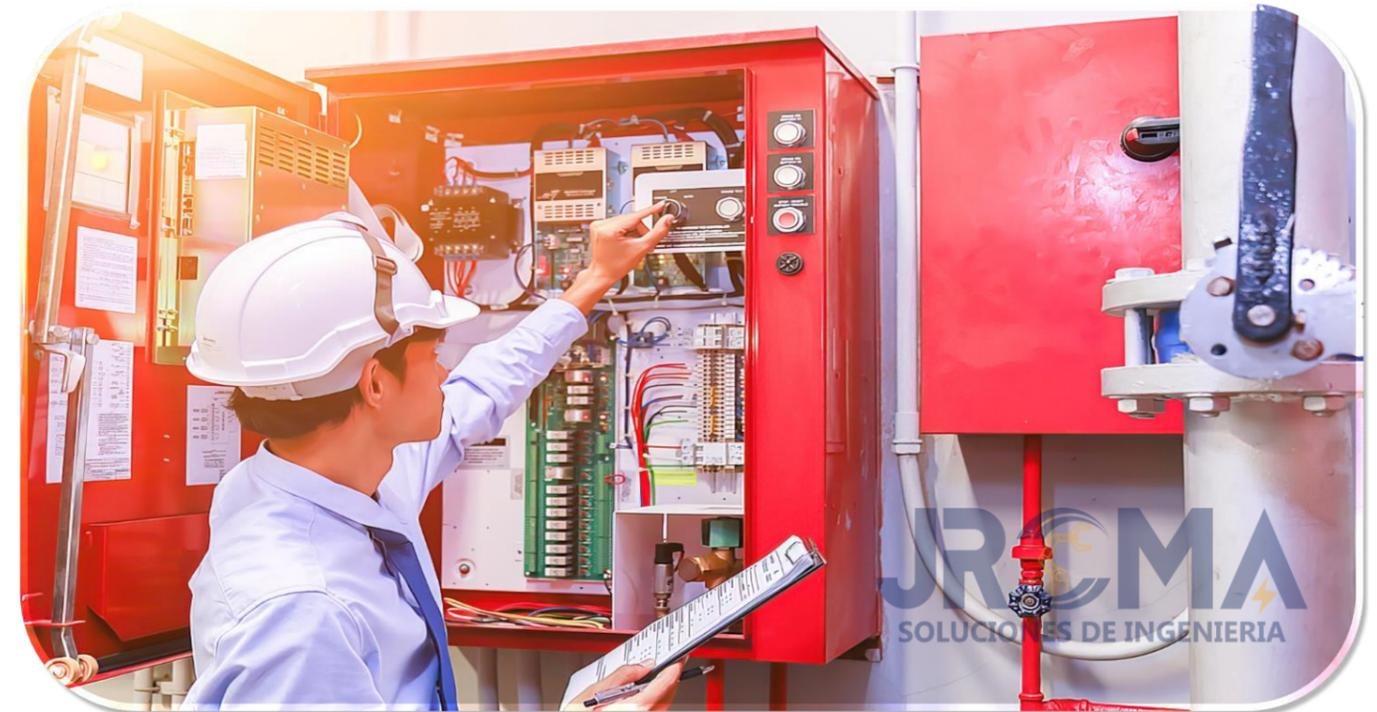
Utilizamos diversos métodos para detectar la presencia de humo, calor o llamas en una determinada área. Los sistemas de detección de incendios son importantes para proteger la seguridad de las personas y las propiedades, y para evitar daños graves causados por incendios.
