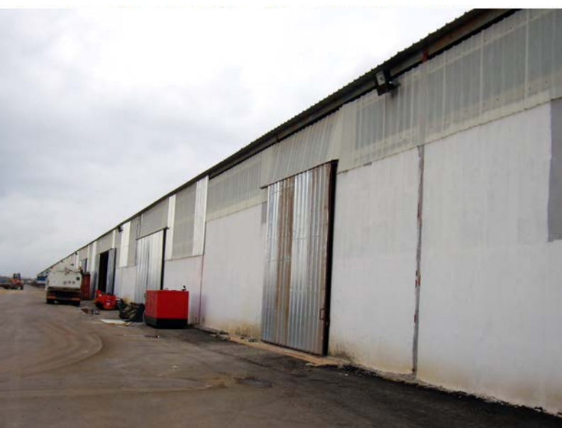
在赤道几内亚劳务分包承建的厂房 Taller de Fábrica Subcontratada con Cooperación de Servicios Laborales en Guinea Ecuatorial
