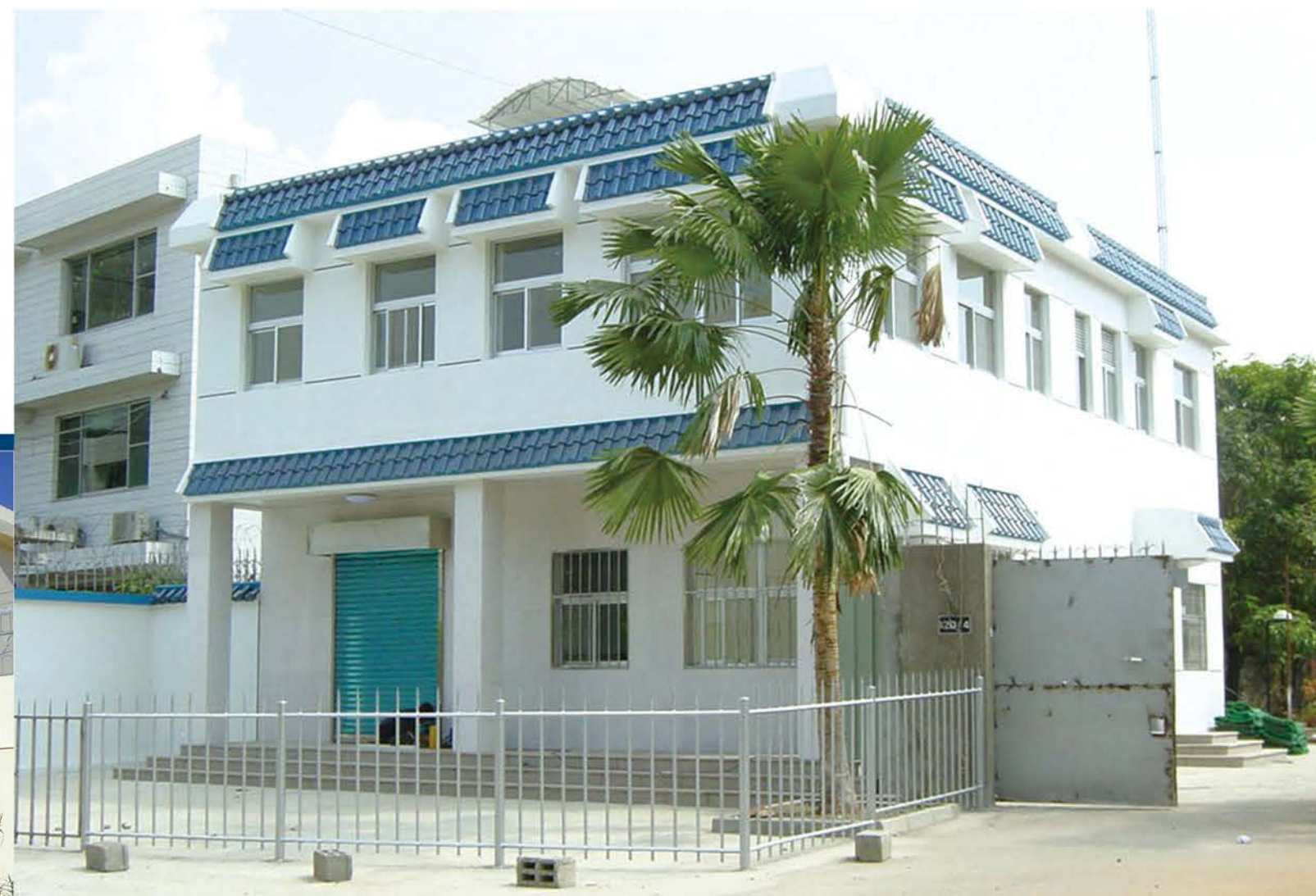
中国驻斯里兰卡使馆签证楼 Edificio de Oficinas de Visados de la Embajada China en Siri Lanka
