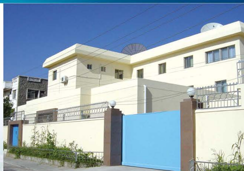
中国驻亚丁总领馆经商处改造工程 Obra de Transformación de la Oficina del Consejero Económico y Comercial, Consulado General de China en Aden
