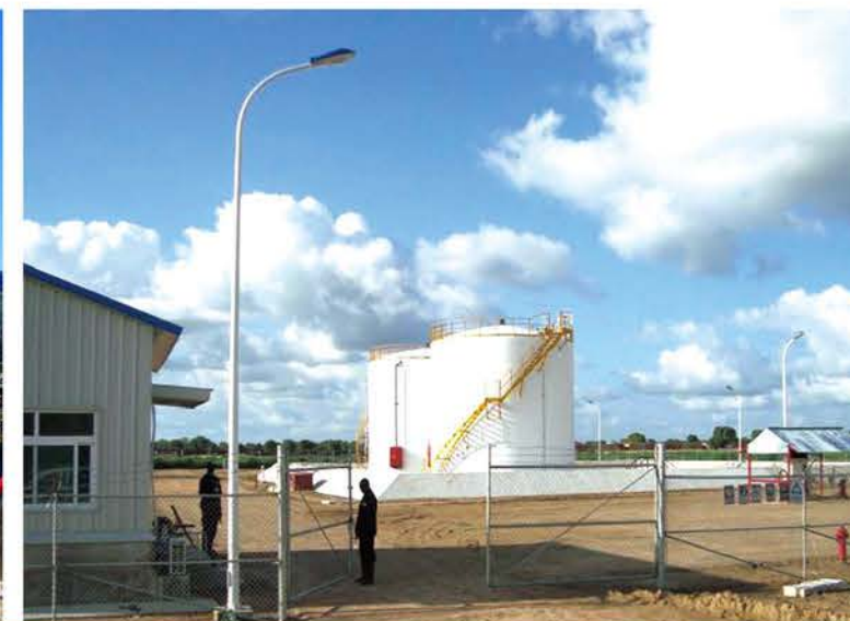
乍得RONIER油田营地配套柴油储油罐工程 Obra Complementaria de Tanques de Diesel para el Campamento Petrolero de Ronier, Chad
