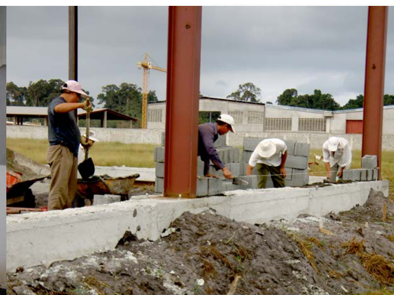
在赤道几内亚劳务分包承建的厂房——施工中 Taller de Fábrica Subcontratada con Cooperación de Servicios Laborales en Guinea Ecuatorial – en media construcción
