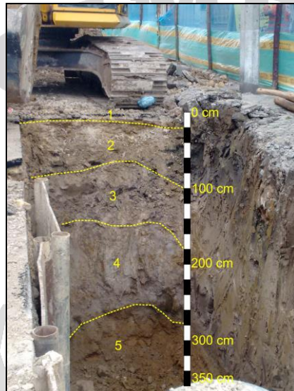
Descripción y análisis de suelos barrio El Progreso, dentro de las obras para el Colector San Agustín. Municipio de Bogotá, D.C., Cundinamarca
