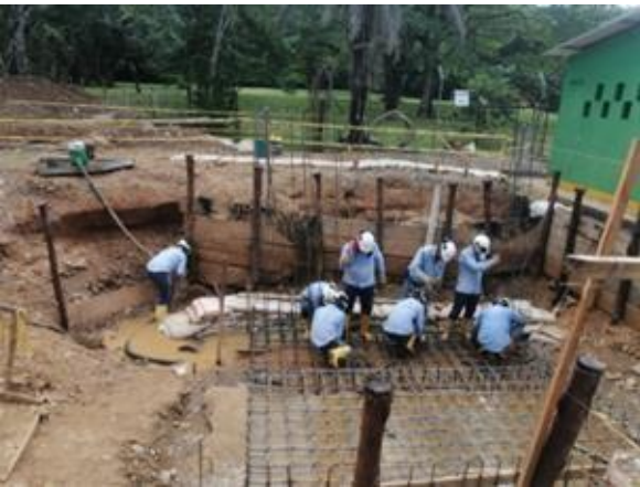
Cimentación Caseta Bocatoma CPF Cup.
