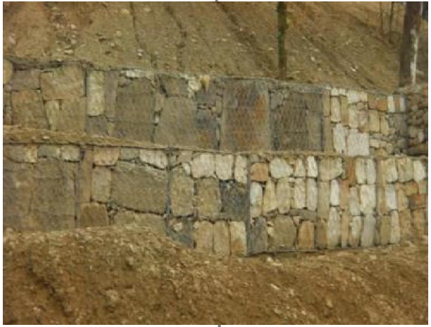
Construcción cajas línea de Impulsión CPF Cup.
