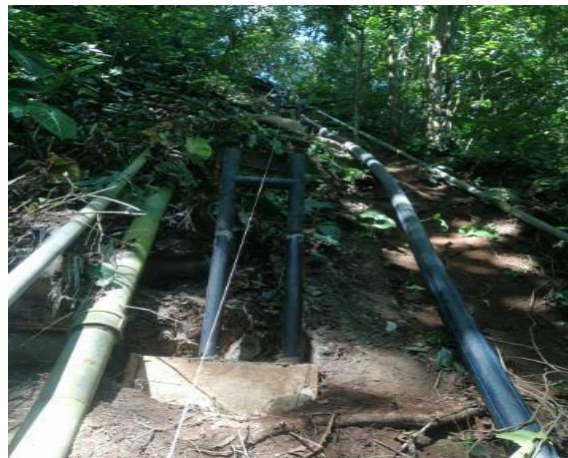
Construcción línea de impulsión Bocatoma CPF Cup.
