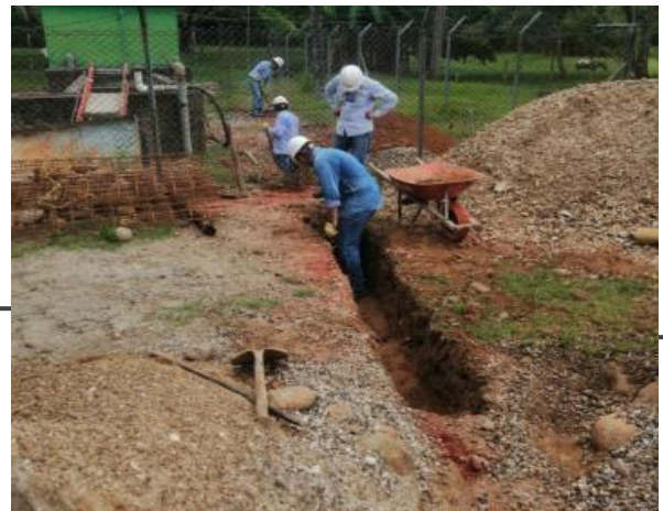
Construcción de banco ducto Bocatoma CPF Cup.
