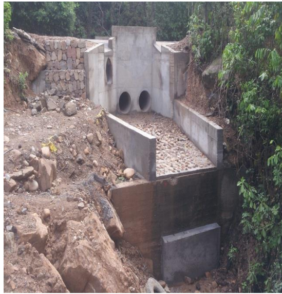
Construcción alcantarillas vía pozos Cup. XB y XH
