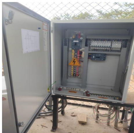
Suministro e Instalación Tablero de control y tablero de potencia para sistema de bombas 1 y 2 CPF Cup.
