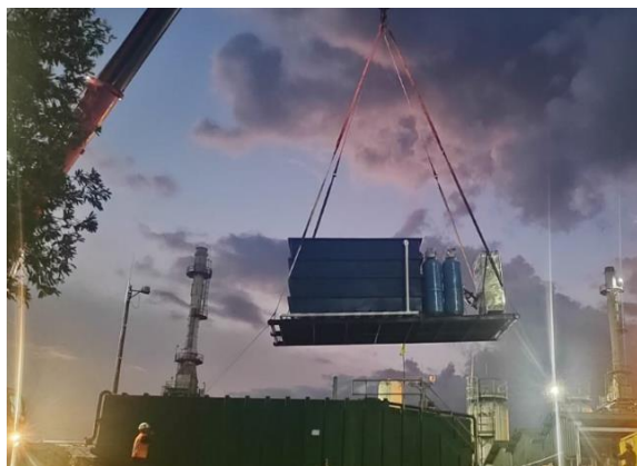
Izaje de PTAP y localización en placa CPF Cup.
