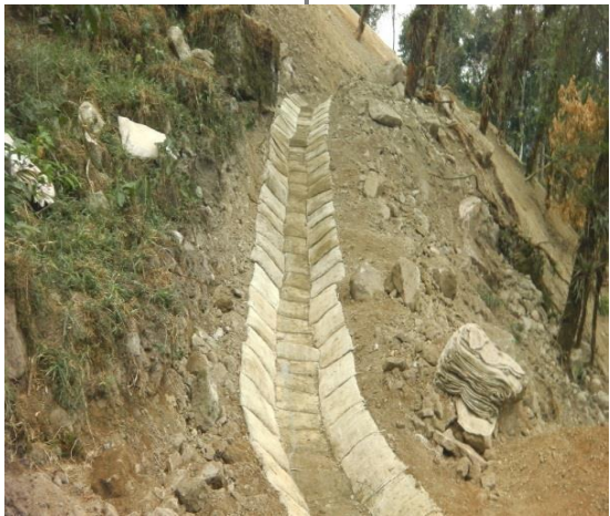
Construcción cajas línea de Impulsión CPF Cup.
