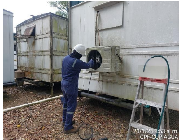
Mantenimiento aires acondicionados CPF Cup.
