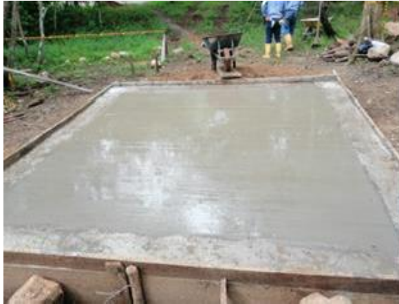
Cimentación Caseta Bocatoma CPF Cup.
