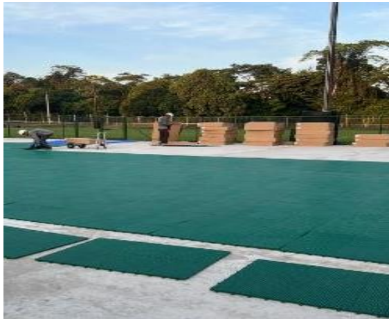
Instalación Piso modular duracourt Canchas CPF Cup.
