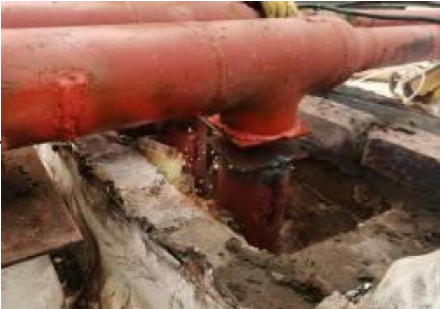
Adecuación y aislamiento línea de flujo hidráulico interna del Casino CPF Cup.
