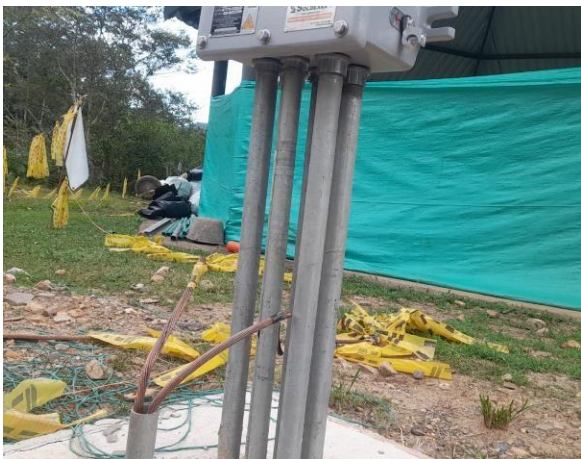
Suministro e instalación sistema eléctrico banco ductos
