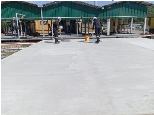
Aplicación de recubrimiento epóxico de placa PTAP.
