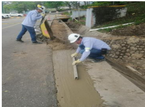
Construcción Cuneta Zona Casino CPF Cup.
