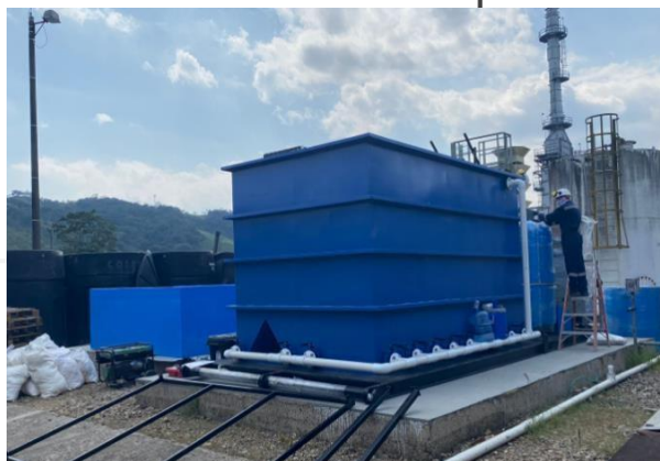
Suministro y puesta en funcionamiento de PTAP en CPF Cup.
