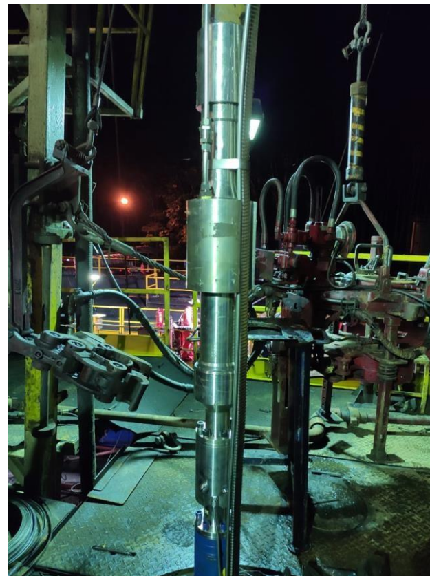
Instalación de inyector en tubería de producción
