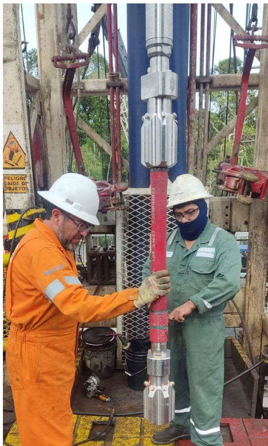
Instalación en tándem para químicos no compatibles
