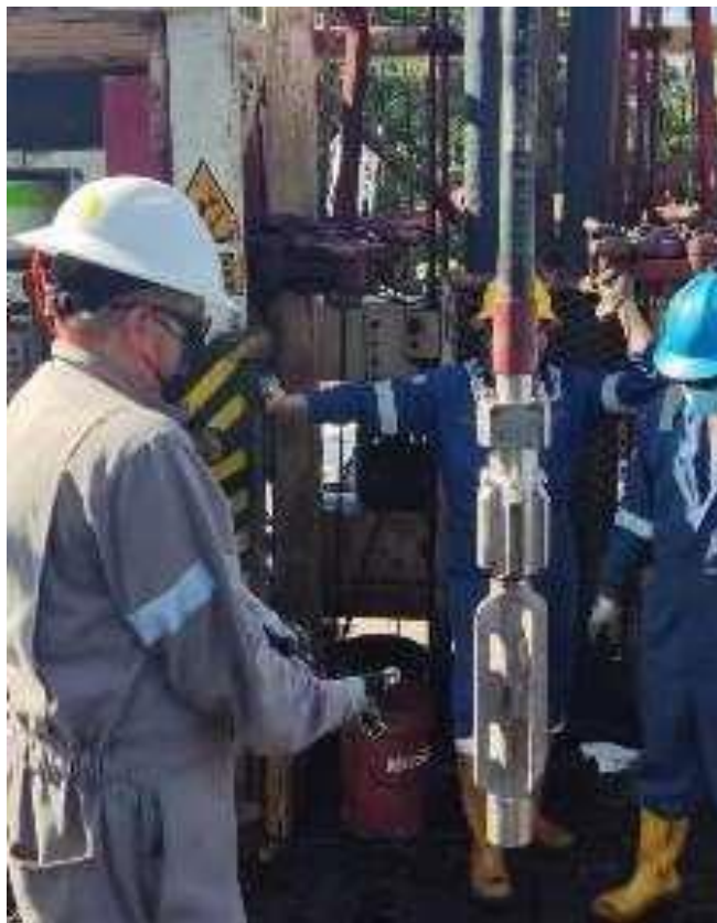
Instalación profundizada con tubería para inyectar en los perforados
