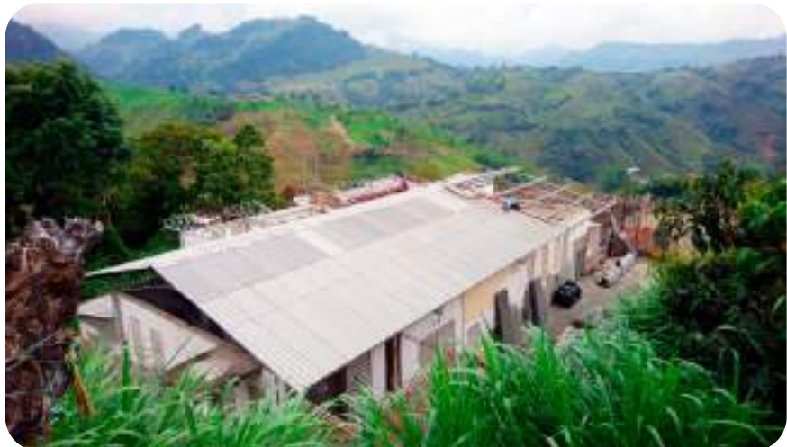
Estructura de cubierta, PBA Aranzazu, Caldas
