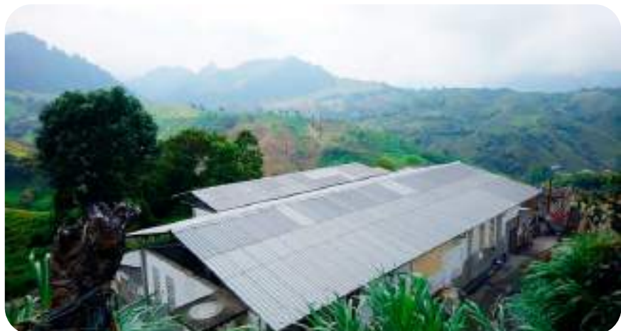
Cubierta, PBA Aranzazu, Caldas
