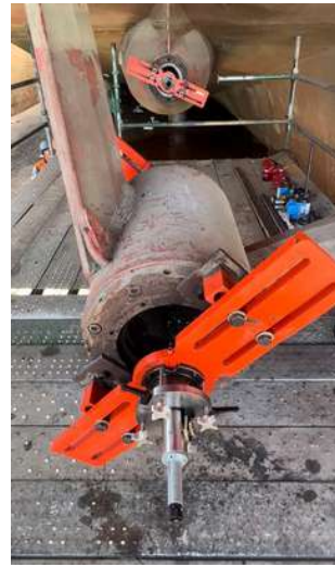
Foto 1. Montaje: Instalación de bases y accesorios de torno portátil Clímax BB5000 y sistema de alineación óptico.
