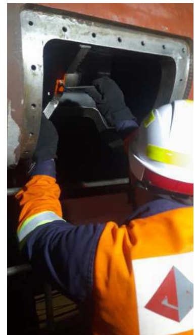
Foto 4. Montaje para mecanizado de portabujes proa, popa y central.
