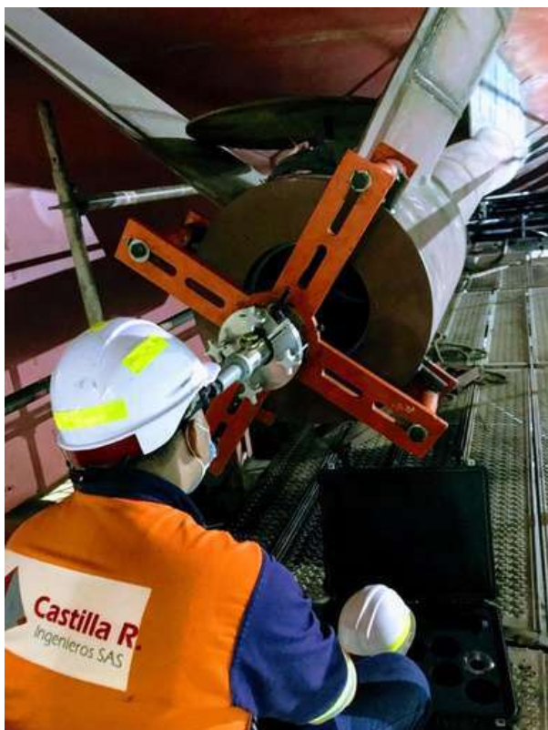
Foto 1. Alineación con telescopio BRUNSON de portabujes de babor.
