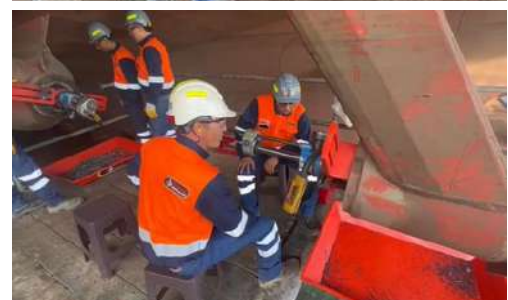
Foto 5. Premaquinado simultaneo en: Portabuje de arbotante, bocina exterior y bocina interior.
