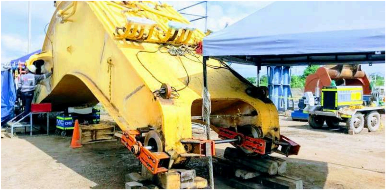
REPARACIÓN DE BOOM KOMATSU 5500 KOMATSU 5500 BOOM REPAIR
