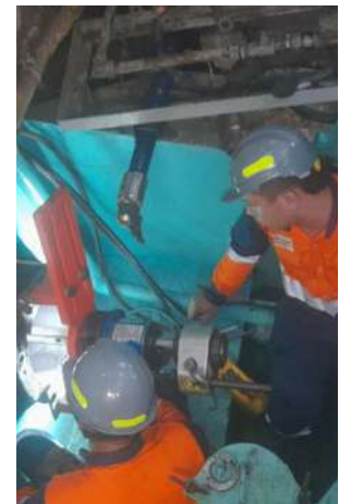
Foto 2. Alineación y verificación con láser del sistema de propulsión.
