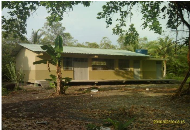
CONSTRUCCION AULA CHONTAL TUMACO
