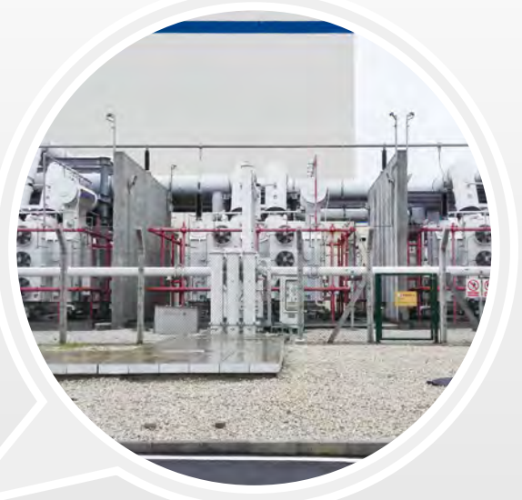
Transformador nuclear de 450MVA, 500kV, utilizado en Karachi Central Nuclear, Pakistán.
