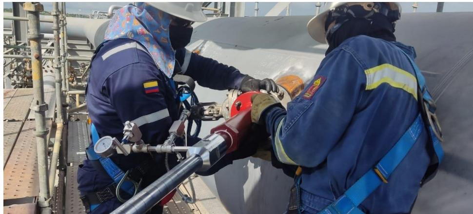
Servicio especializado de 4 Hot Tap de 3" e instalación de transductor de flujo ultrasónico y su inspección de integridad en tubería 72" ANSI 150, con espesor de  $\frac{3}{4}$ ". Soldadura, inspección.
