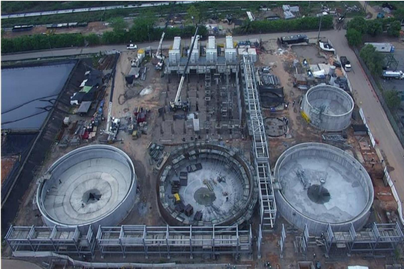
Obras de construcción Mecánicas, civiles y de instrumentación, clarificadores, espesador y bodega de residuos sólidos asociados al proyecto de actualización tecnológica de la planta de tratamiento de aguas residuales de la GRB. Instalación y puesta en operación de los equipos, facilidades e instrumentos asociados al proyecto de actualización tecnológica PTAR.
