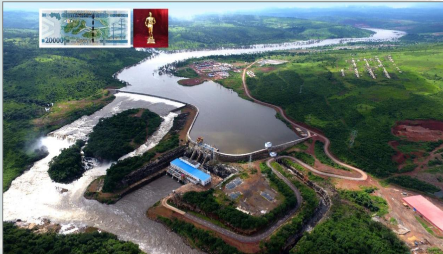
EPC de la Central Hidroeléctrica Kaleta de 240MW, Guinea
