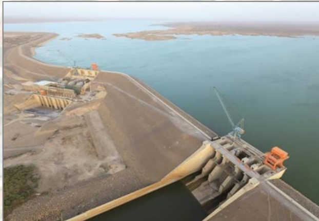
Complejo de presas del proyecto Upper Atbara, Sudán
