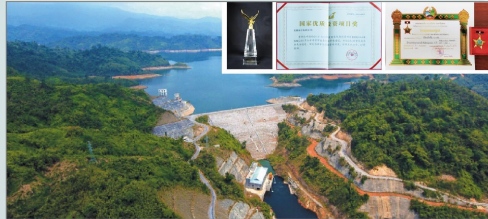
Central Hidroeléctrica Nam Lik 1-2 de 100MW, Laos
