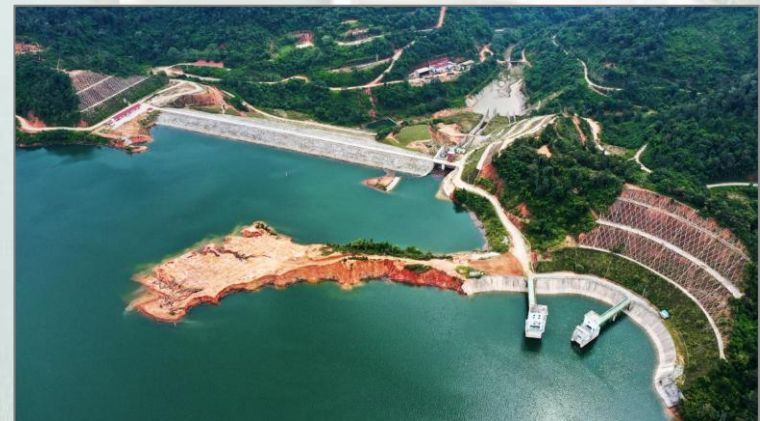
Central Hidroeléctrica Nam Ngiep de 180MW, Laos
