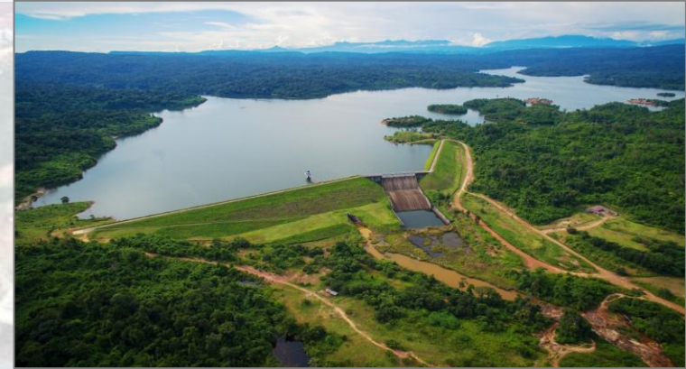
Central Hidroeléctrica Nam Leuk de 60MW, Laos
