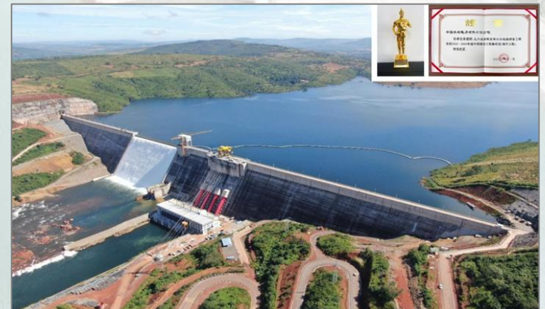
Central Hidroeléctrica Soaupiti de 450MW, Guinea
