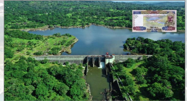
Central Hidroeléctrica Kinkon de 3,45MW, Guinea
