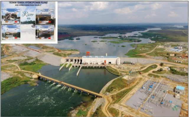
Central Hidroeléctrica Isimba de 183MW e interconexión Isimba – Bujagali, Uganda
