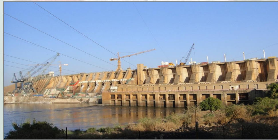
Aumento de altura de la presa de Roseires, Sudán
