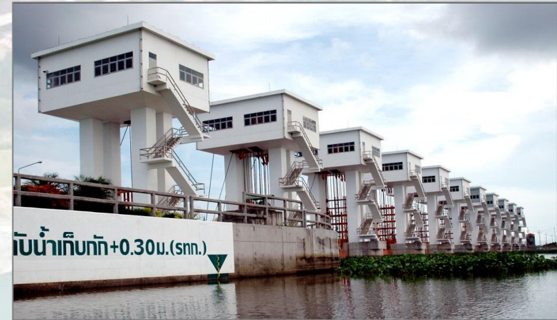
Presa de derivación de Pak Phanang y edificios anexos, Tailandia
