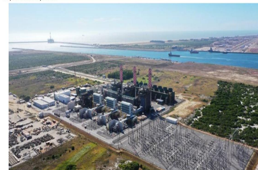
LNG TERMINAL ACCIONA BRAZIL
