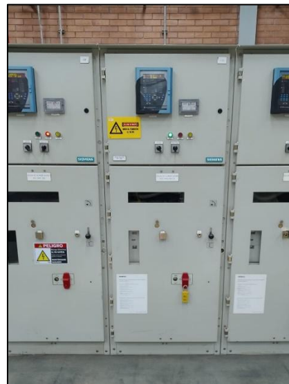
Decomisionamiento de Variadores de 3500 HP en el CCM del EBR (En ejecución).
