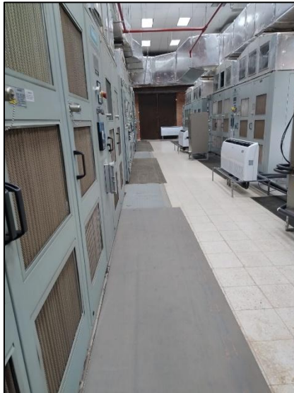
Decomisionamiento de Variadores de 3500 HP en el CCM del EBR (En ejecución).
