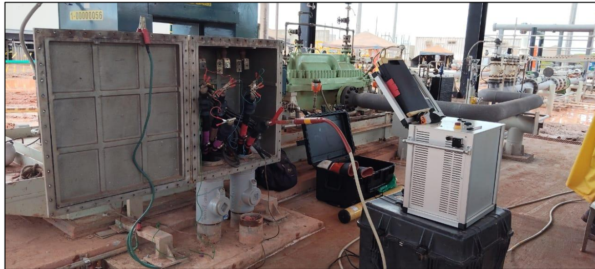
Prueba VLF a acometida de bomba Principal en la estación de bombeo CAÑO SUR
