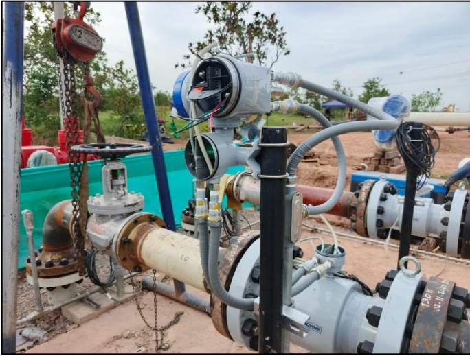
Pruebas de verificación e instalación de instrumentos en pozo inyector.
