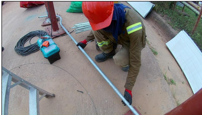
Instalación de puesta tierra a pórticos
