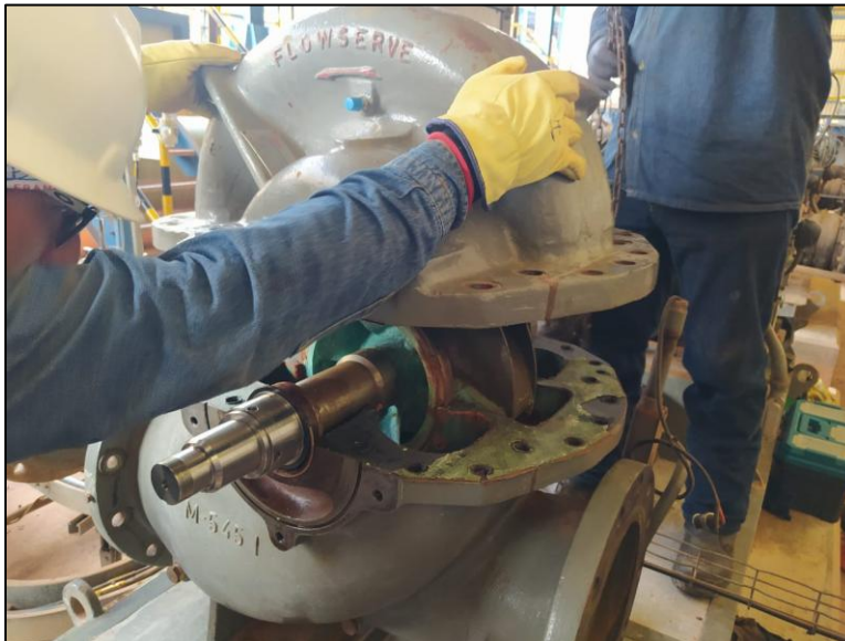
Mantenimiento Preventivo y Correctivo para bombas (PROYECTO SAARA)
