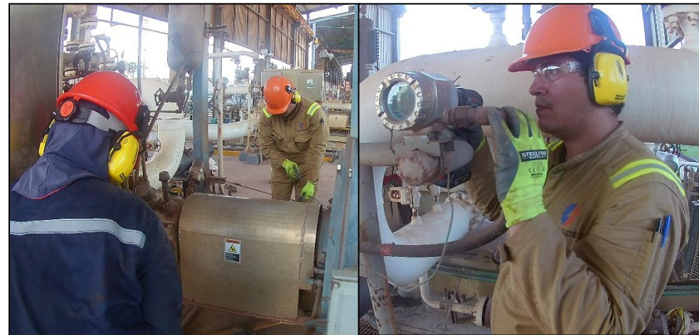
Decomisionamiento de bombas de 3500 HP
