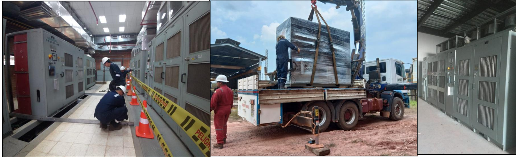
Decomisionamiento de variadores y traslados de estos desde EBR a Caño Sur, e instalación.
