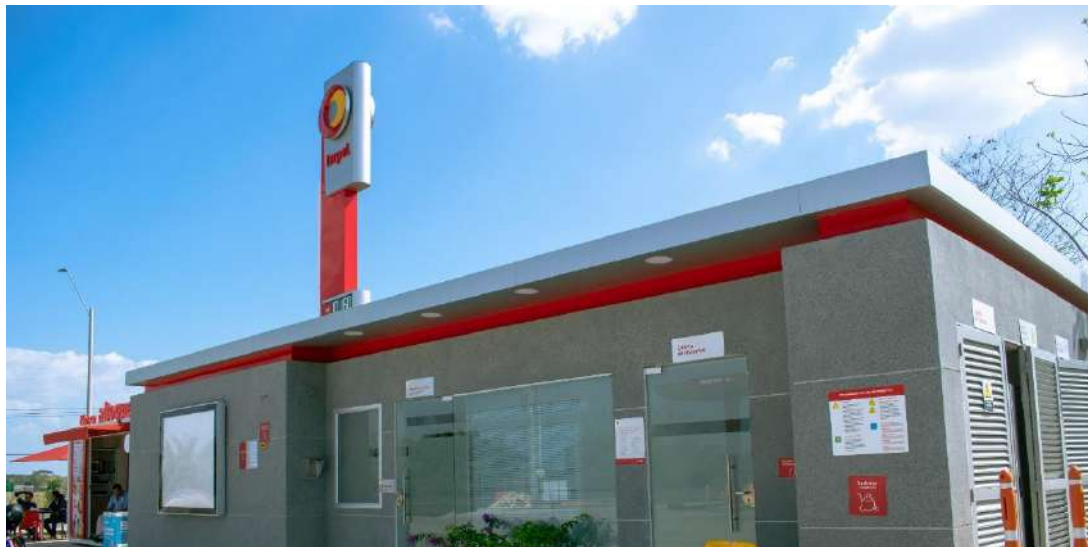
2022 Construcción de obras civiles y eléctricas EDS Guadalupana – Montería.
