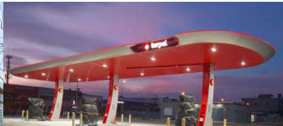
2021 Construcción de obras civiles y eléctricas EDS Avenida – Montería
