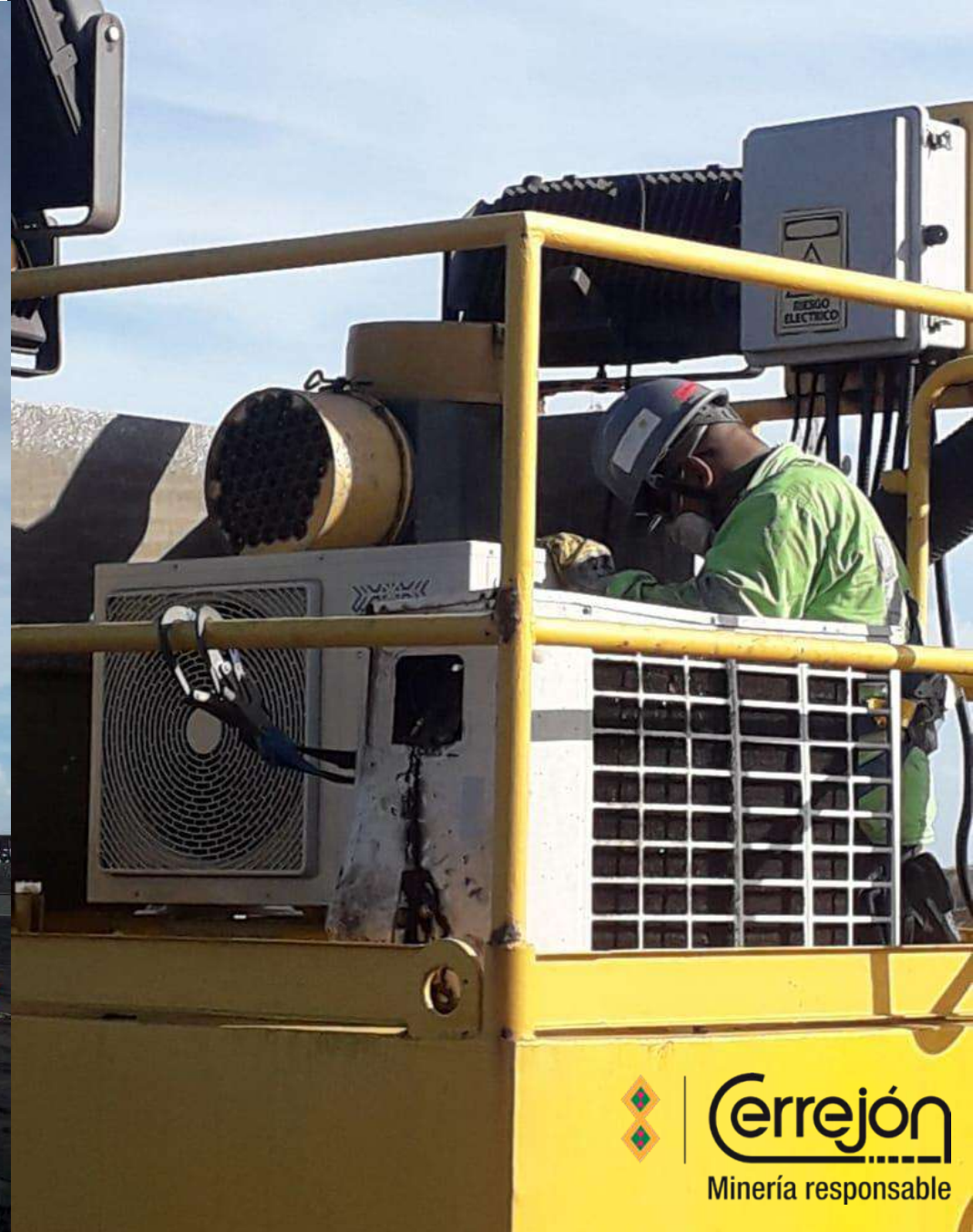
2020 – Cambio de Equipo mini Split de 2 TR en cabina del operador de apilador de reclamador N° 3, en PBV.
