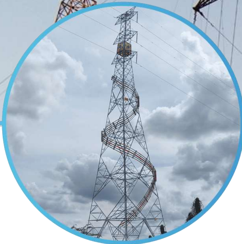
Diseño estructural torre estética : Línea de transmisión Riohacha – Cuestecitas, Riohacha – Maicao a 110kV. (Colombia) Cliente: CONSORCIO CDEM
