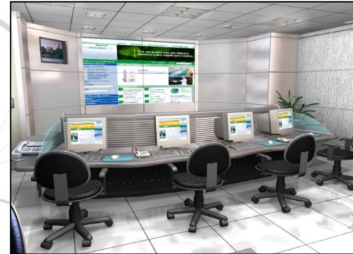
Centro de Operaciones
