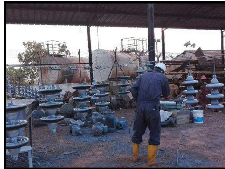
APLICACIÓN DE RECUBRIMIENTO SILICONADO 570 A PORTICO DE 34.5KV INCLUYE: ( 9 CADENAS DE 4 AISLADORES, RECONECTADOR 34.5, JUEGO DE DP'S, SECCIONADORA DE 34.5KV) CAMPO APIAY -ECOPETROL
