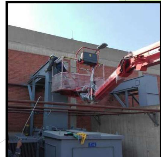
APLICACIÓN DE RECUBRIMIENTO SILICONADO SI COAT 579 EN BOMBAS AP AP7364K, AP7364L y AP7364I INCLUYE DUCTO- ESTACION ACACÍAS-ECOPETROL:
