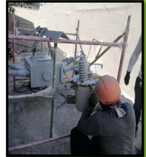
*Se realiza el cambio de los equipos afectados por la contaminación y corrosión. (Seccionalizador - Transformador y aisladores), posterior a ello se procede a aplicar recubrimiento Silicón Si-Coat579 para su protección.*
