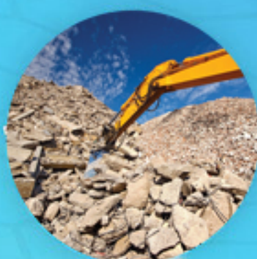
Residuos de Construcción y Demolición
