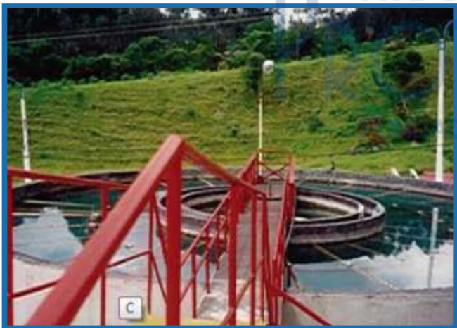
CLARIFICADOR DE SEDIMENTACIÓN ACELERADA (ACUEDUCTO LA ENEA)
