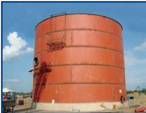
Tanques de acero carbono API 650/652
