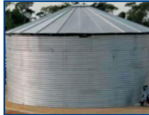
Tanques tipo australiano
