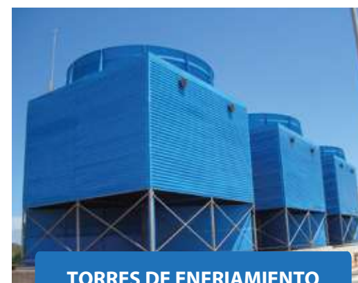
TORRES DE ENFRIAMIENTO
