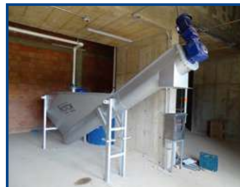
Tornillos Clasificadores de arena
