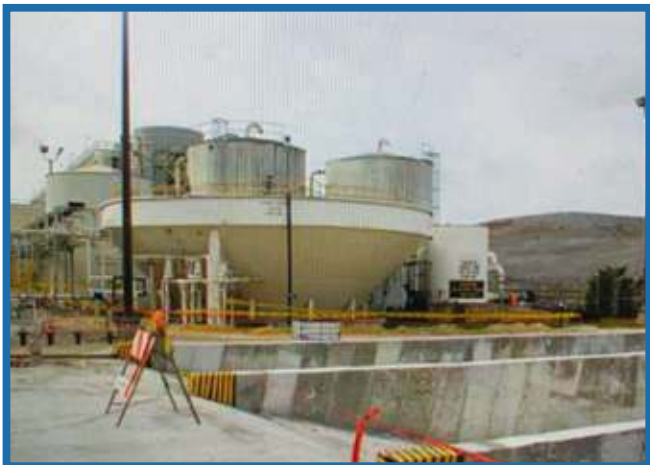
CLARIFICADOR DE SEDIMENTACIÓN ACELERADA (NOSTE MANAGEMENT -DORAL)
