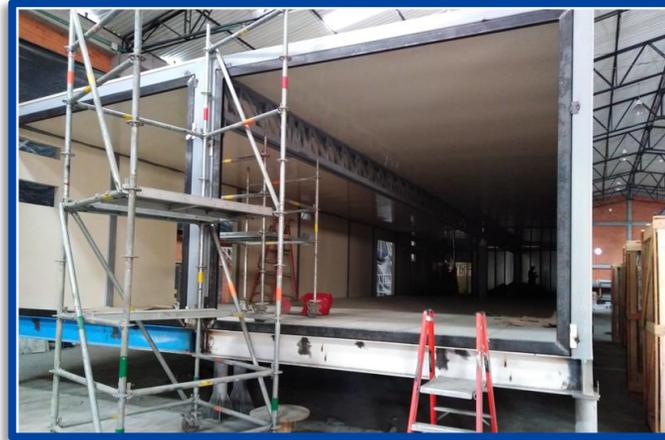
Metalmecánica liviana lámina ASTM A36 Cal 12 Exterior Galvanizada A653 G60 calibre 18 Interior
