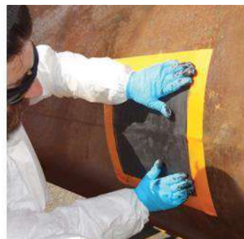
Aplicación de 5 capas de Kevlar® con resina 3X
