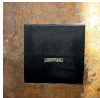
TANKiT® instalado. Trazabilidad de la reparación
