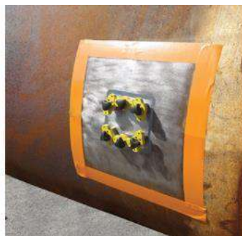
Aplicación de lámina de acero (con filler e imanes)
