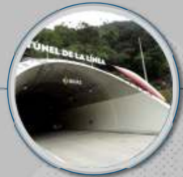
Tunel La Linea
