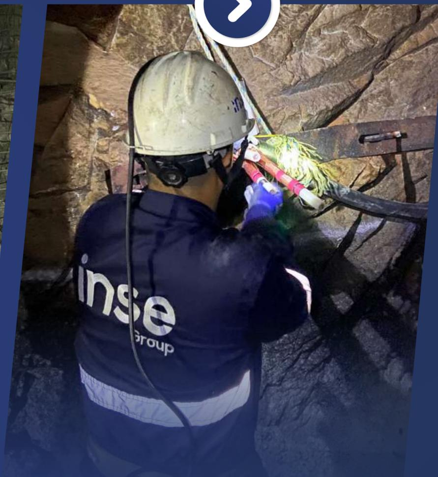
**Reparación en frío y caliente de cables de goma**
