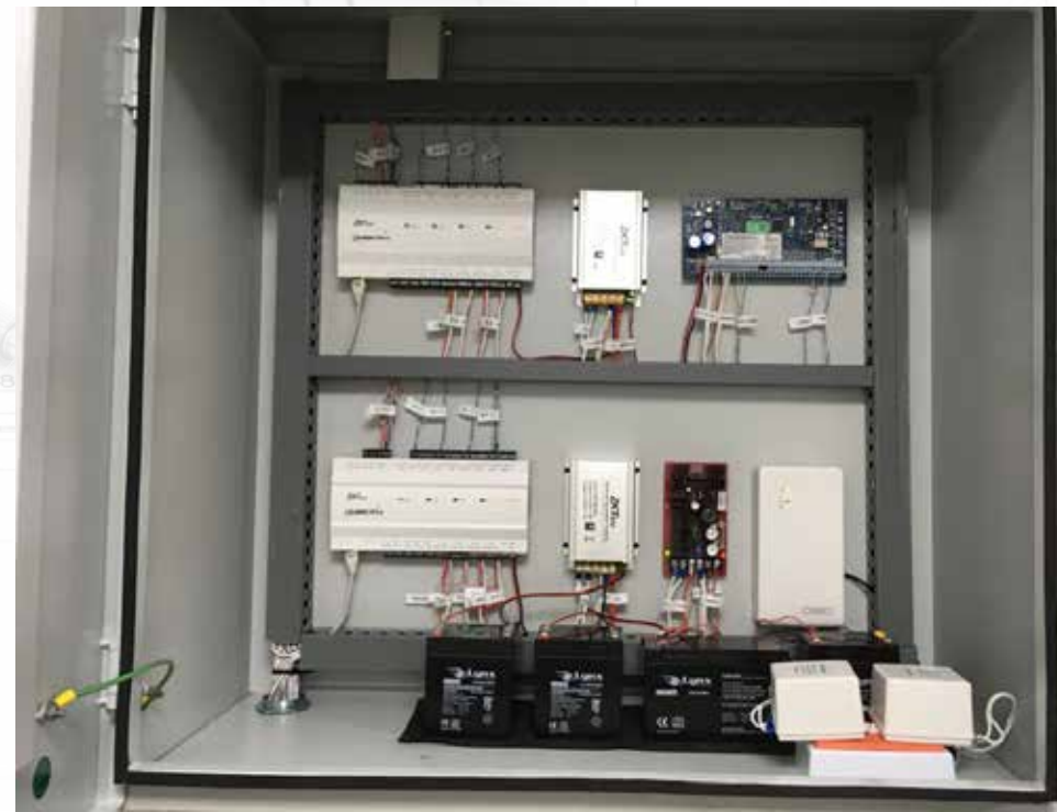
Seguridad electrónica - Tablero sistema de control de acceso e instrucción Sede para los refugiados ACNUR CALI
