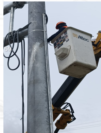
ENERGIZACIÓN PMV - HINCADO DE POSTES PARA RED DE MT SOACHA - GIRARDOT (CUNDINAMARCA)
