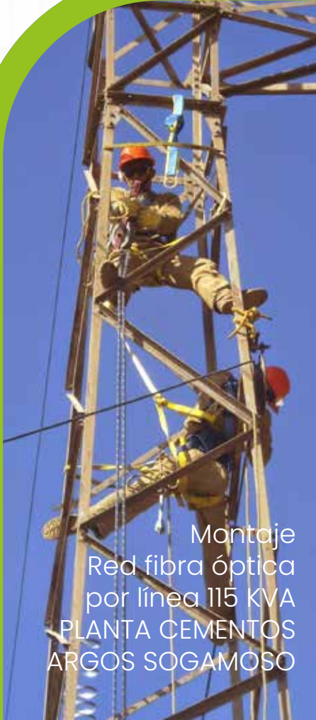
▲ Montaje Red fibra óptica TERMO PAIPA SOCHAGOTA
