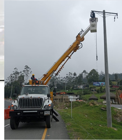
ENERGIZACIÓN PMV - HINCADO DE POSTES PARA RED DE MT SOACHA - GIRARDOT (CUNDINAMARCA)
