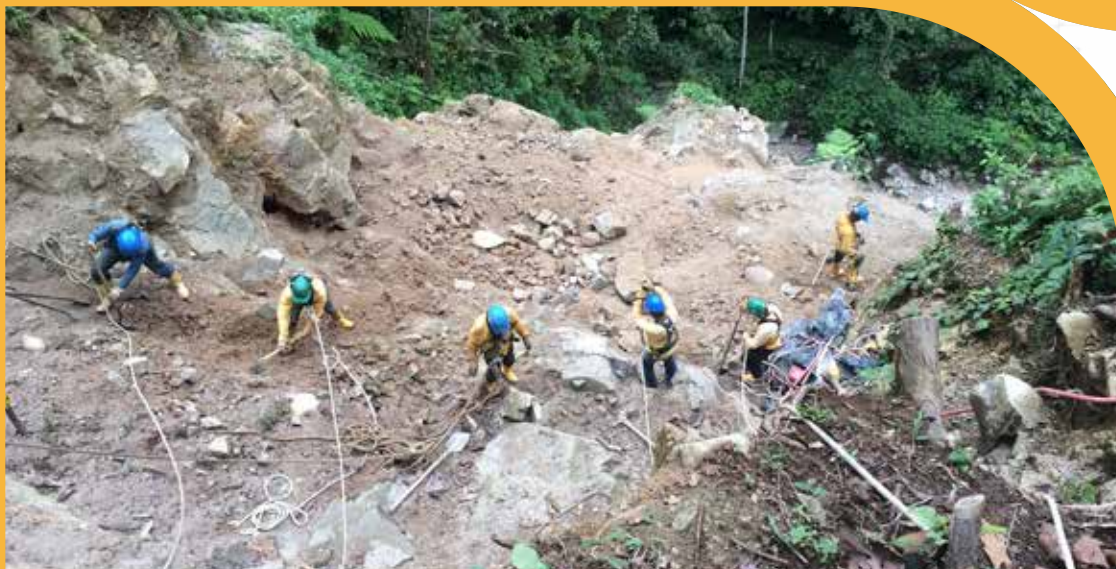
Demolición controlada de roca PUENTE CAMPUCANA - MOCOCHA
