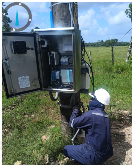
TENDIDO DE FIBRA ÓPTICA CONFIGURACION DE EQUIPOS Apiay (Villavicencio)
