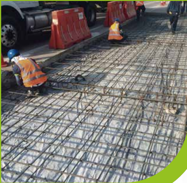
Placa de concreto, báscula de pesaje LA LIZAMA RUTA DEL SOL
