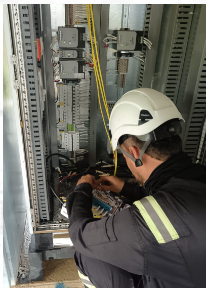
TENDIDO DE FIBRA ÓPTICA CONFIGURACION DE EQUIPOS Apiay (Villavicencio)
