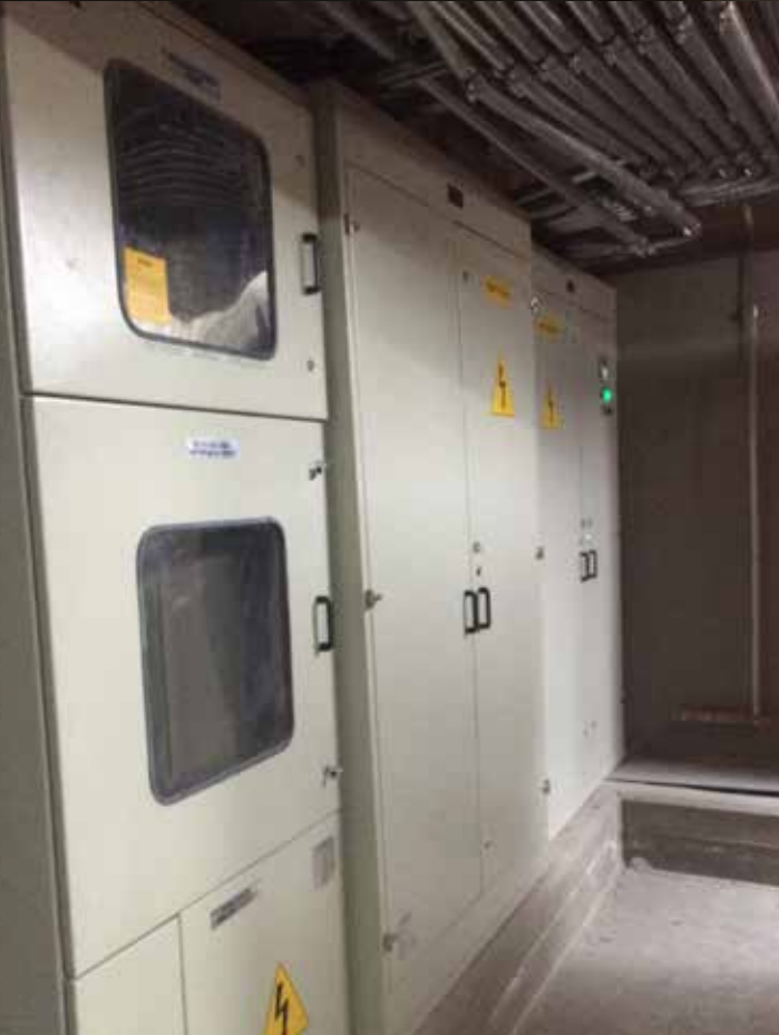
Proyecto Davinci Diseño y construcción Red eléctrica e iluminación
