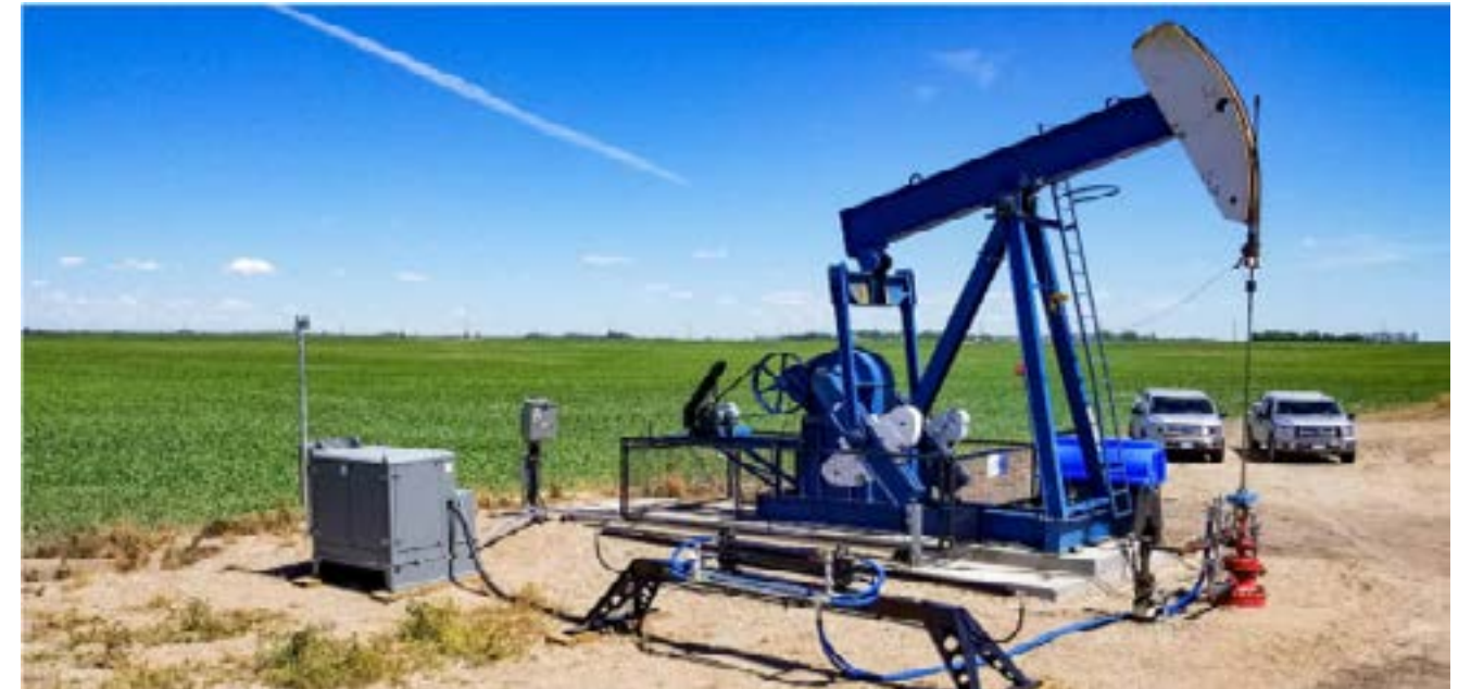
UARV RCOM: CONTROL REMOTO Y SISTEMA DE MONITOREO
