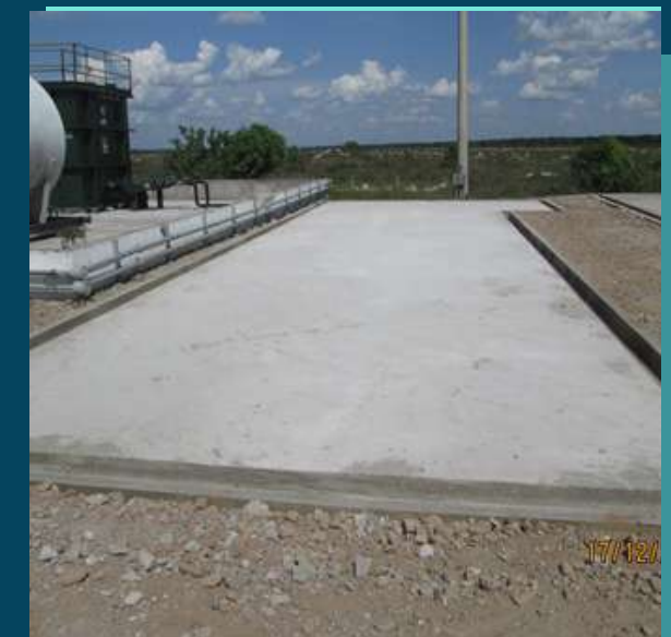
Obras Civiles para Facilidades Petroleras.
