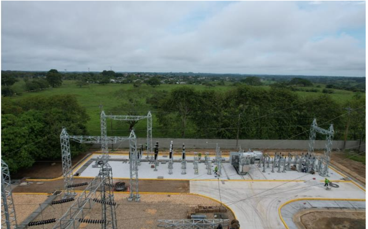
Bahías 115KV y 34.5KV SE Planeta Rica
