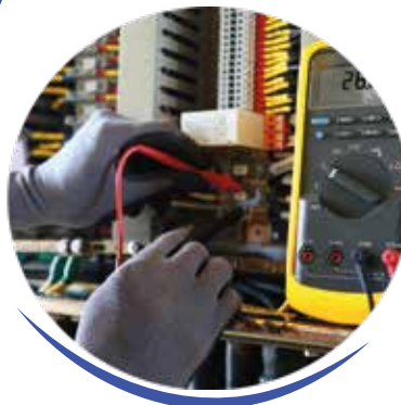
Canalizaciones y ducterías
