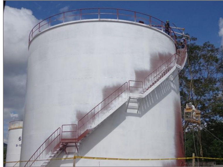
Aplicación de pintura
