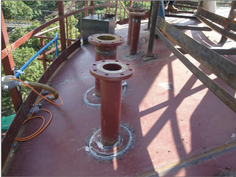
Instalación accesorios techo
