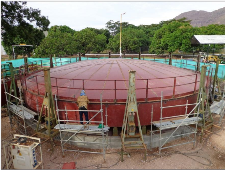
Soldadura láminas del techo al ángulo bocel e instalación de baranda
