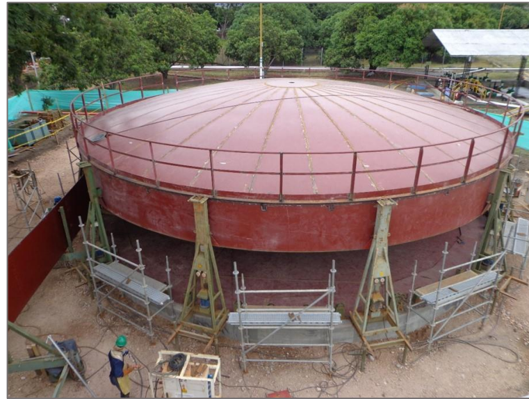
Izaje de tanque para ingreso de sexto anillo
