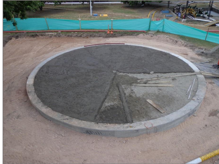
Aplicación arena asfalto
