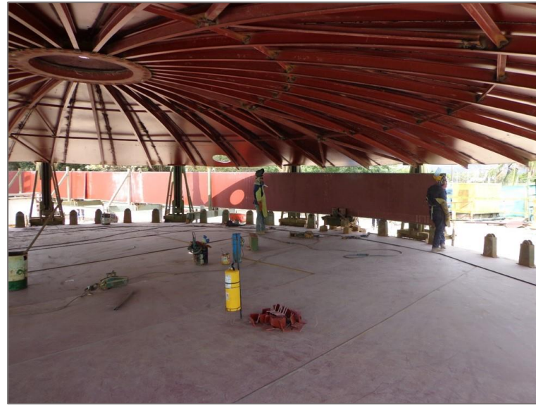
Izaje de techo para ingreso del anillo No. 7
