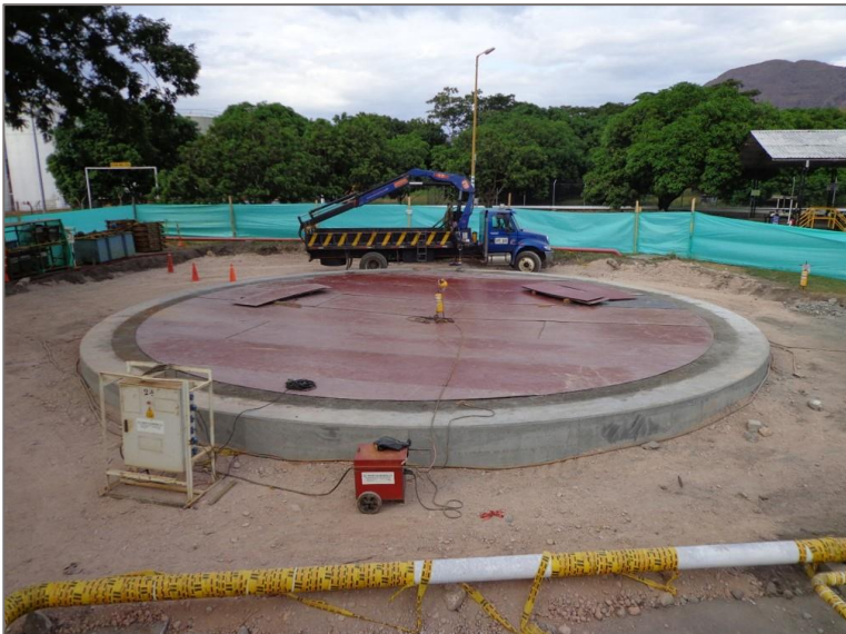
Montaje láminas de fondo
