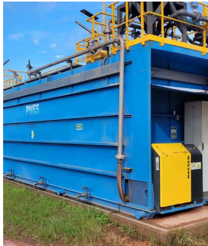
Tratamiento y recuperación para reúso de agua mediante Bio-reactores de membranas (MBR)
