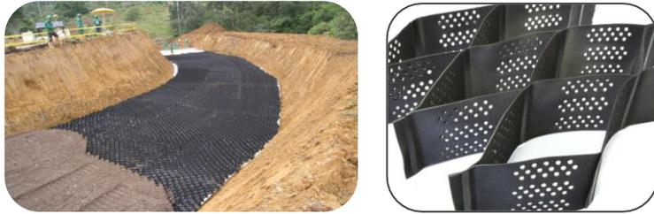
Las Geoceldas son un sistema tridimensional de confinamiento celular que permite, mediante la creación de un suelo artificial, conseguir una buena compactación del terreno, un buen drenaje y el establecimiento de la vegetación.
